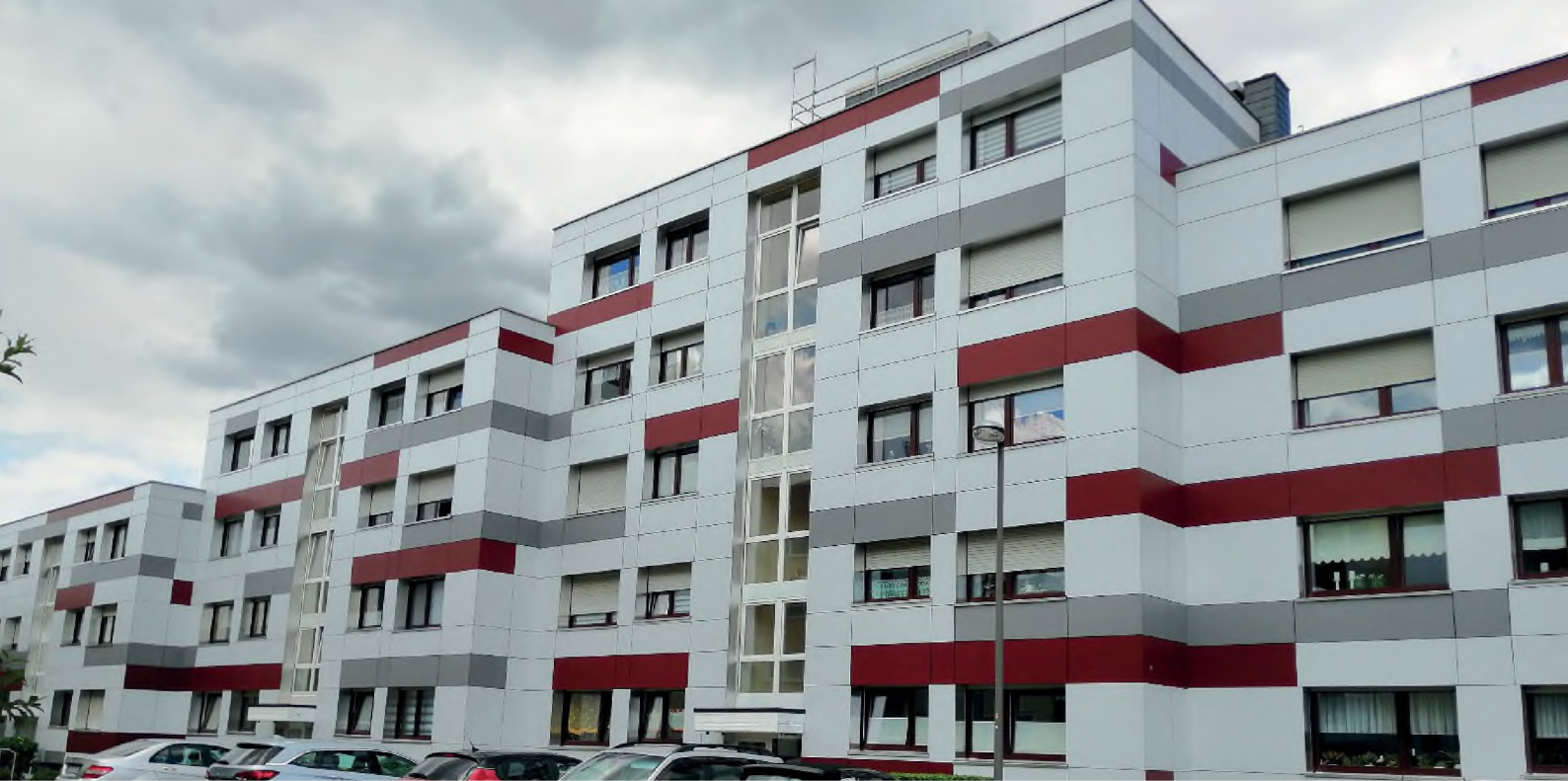
Wülfrath, Föhrenweg, energetische Sanierung der Fassade einer drei- bis fünfgeschossigen Wohnanlage aus den neunzehnhundertsiebzig Jahren, 2017, LPH. HOAI: 1 - 6
