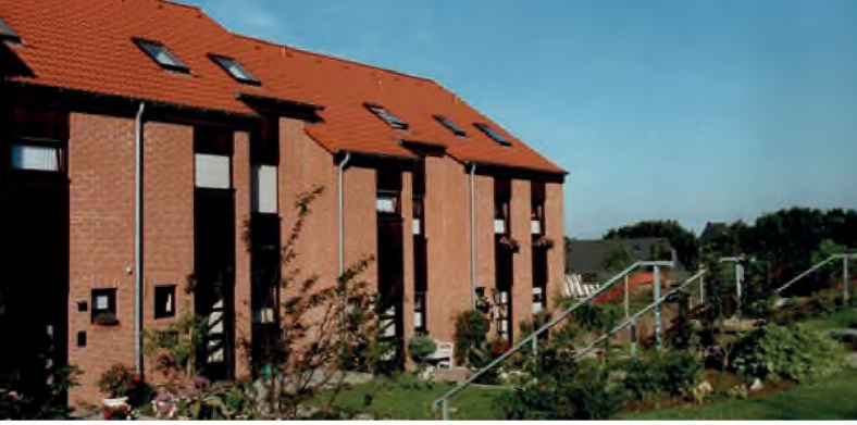
Solingen, Bergfeld, 4 Einfamilienreihenhäuser, 1986, LPH. HOAI: 1 – 9 und Projektentwicklung für einen Bauträger
