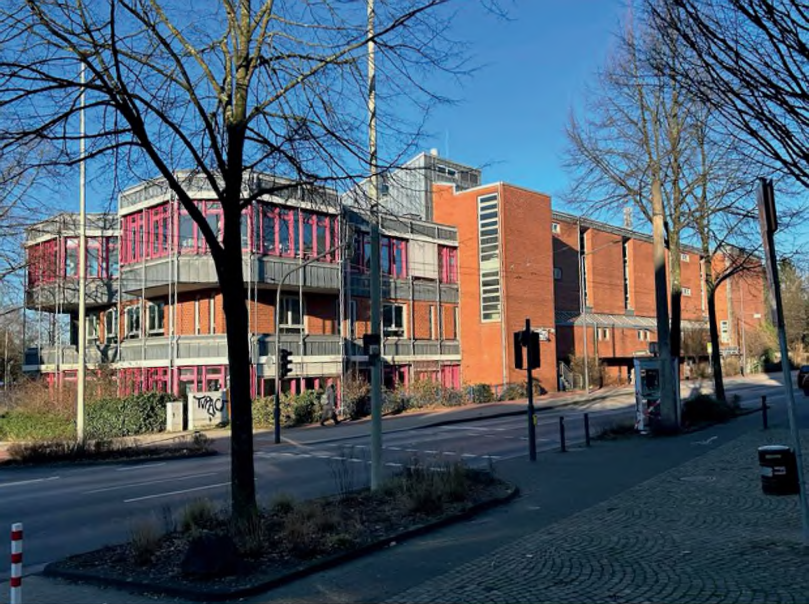
Solingen, Altenhofer Straße, Gesamtschule Solingen- Wald (Friedrich- Albert- Lange- Schule), 5.500 m 2 Nutzfläche, 1994, LPH. HOAI: 5. u. 8, im Auftrag des Büros Günther Mertens, Architekt BDA, Solingen
