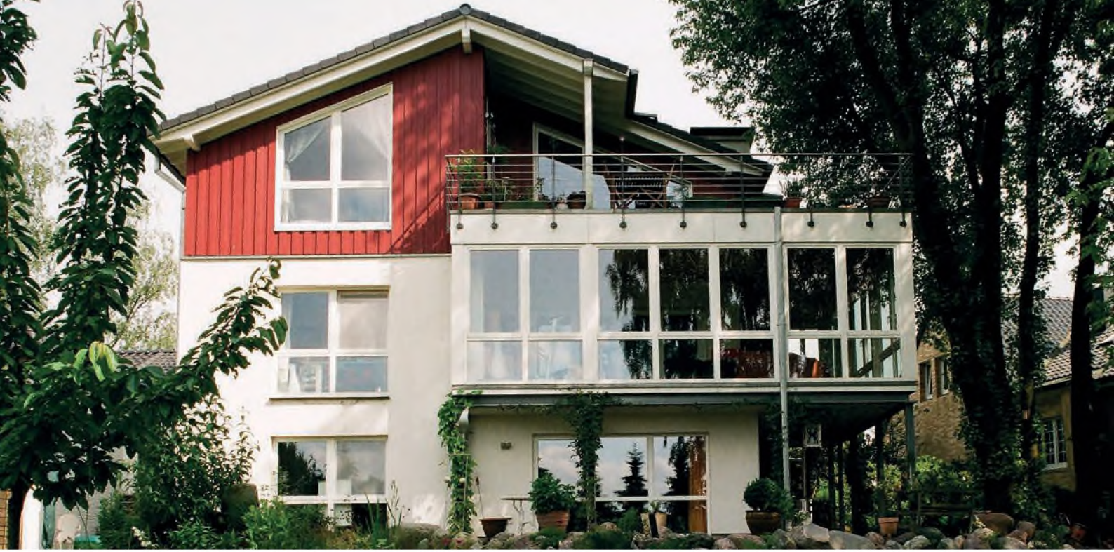
Solingen, Sperlingsweg, Umbau, Erweiterung, Kernsanierung und Modernisierung eines Wohnhauses aus den 1950er Jahren, Wohnfläche 305 m 2 , 2006, LPH. HOAI: 1 – 9
