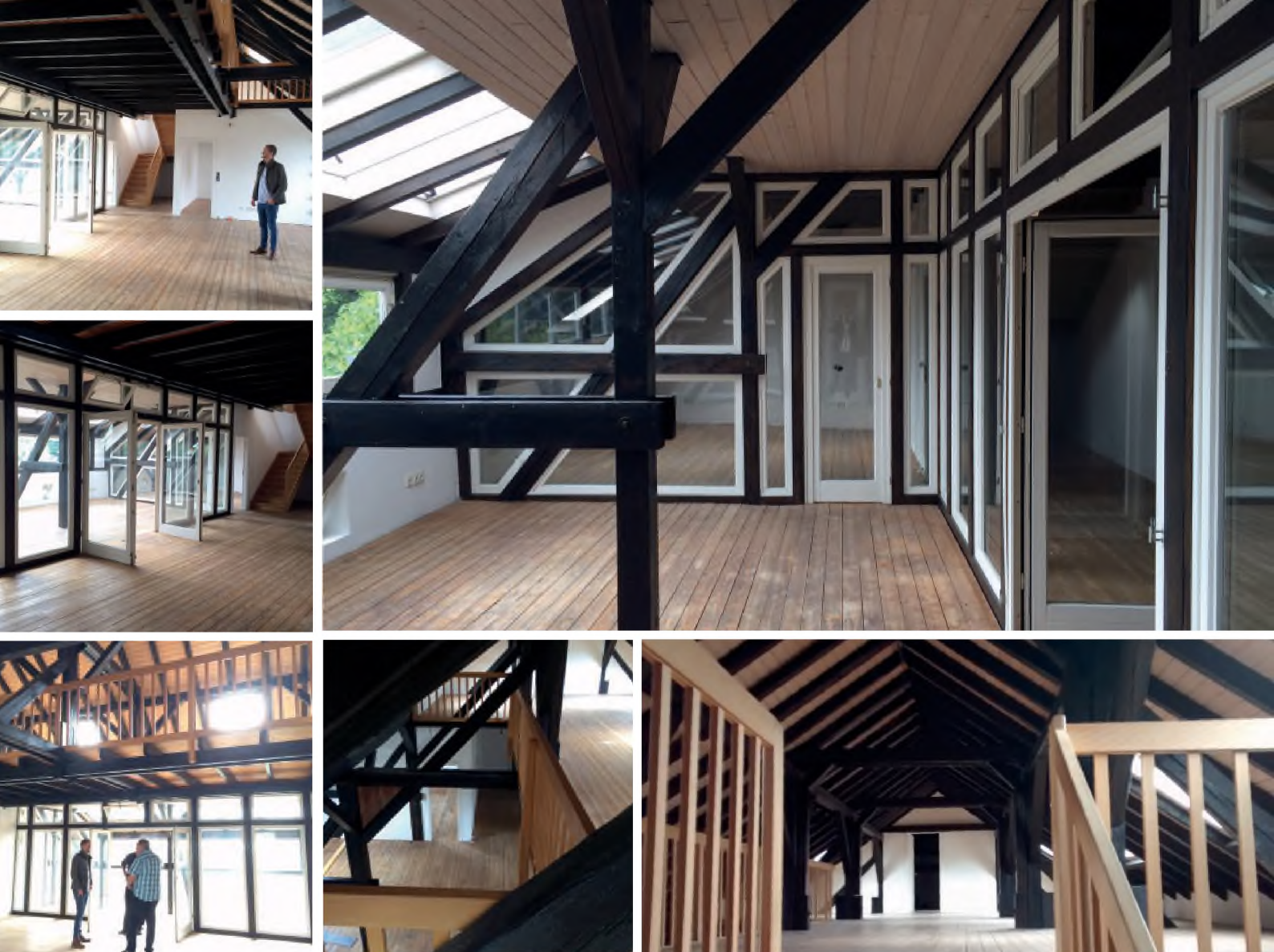
Solingen, Neuenhofer Straße, Sanierung, Rekonstruktion, Umbau und Modernisierung eines ehemaligen Brauereigebäudes aus der Gründerzeit, Nutzfläche 1.600 m 2 , 1990, LPH. HOAI: 1 – 9
