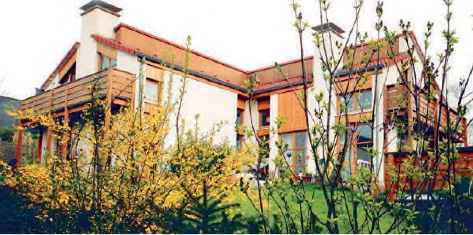
Solingen, Höhscheider Hof, 2 Einfamiliendoppelhaushälften, 1992, LPH. HOAI: 1 – 8
