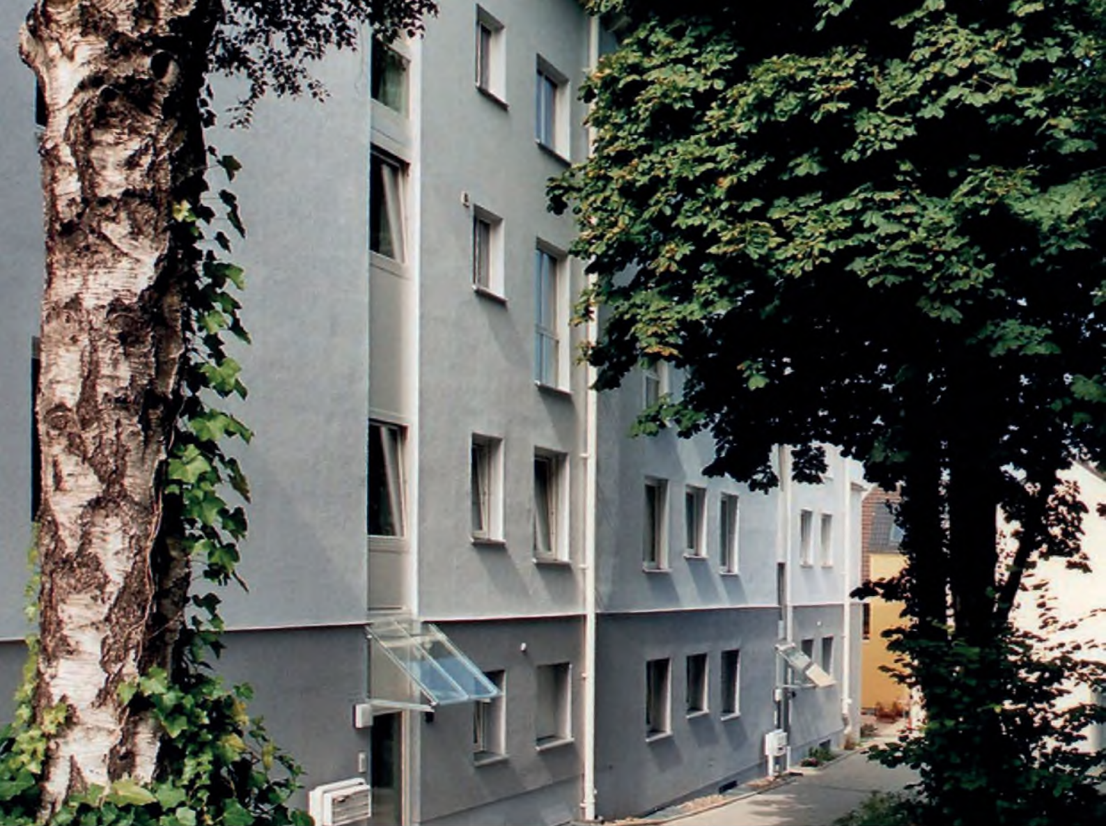
Solingen, Vorländer Straße, Aufstockung, Umbau, Umnutzung und Instandsetzung eines ehemaligen Büro- und Lagergebäudes zu einem Mehrfamilienwohnhaus, Wohnfläche 1.500 m 2 , 2002, LPH. HOAI: 1 – 5
