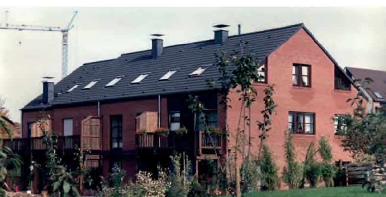
Solingen, Bergfeld, 4 Einfamilienreihenhäuser, 1998, LPH. HOAI: 1 – 9 und Projektentwicklungsleistungen für Bauträger.
