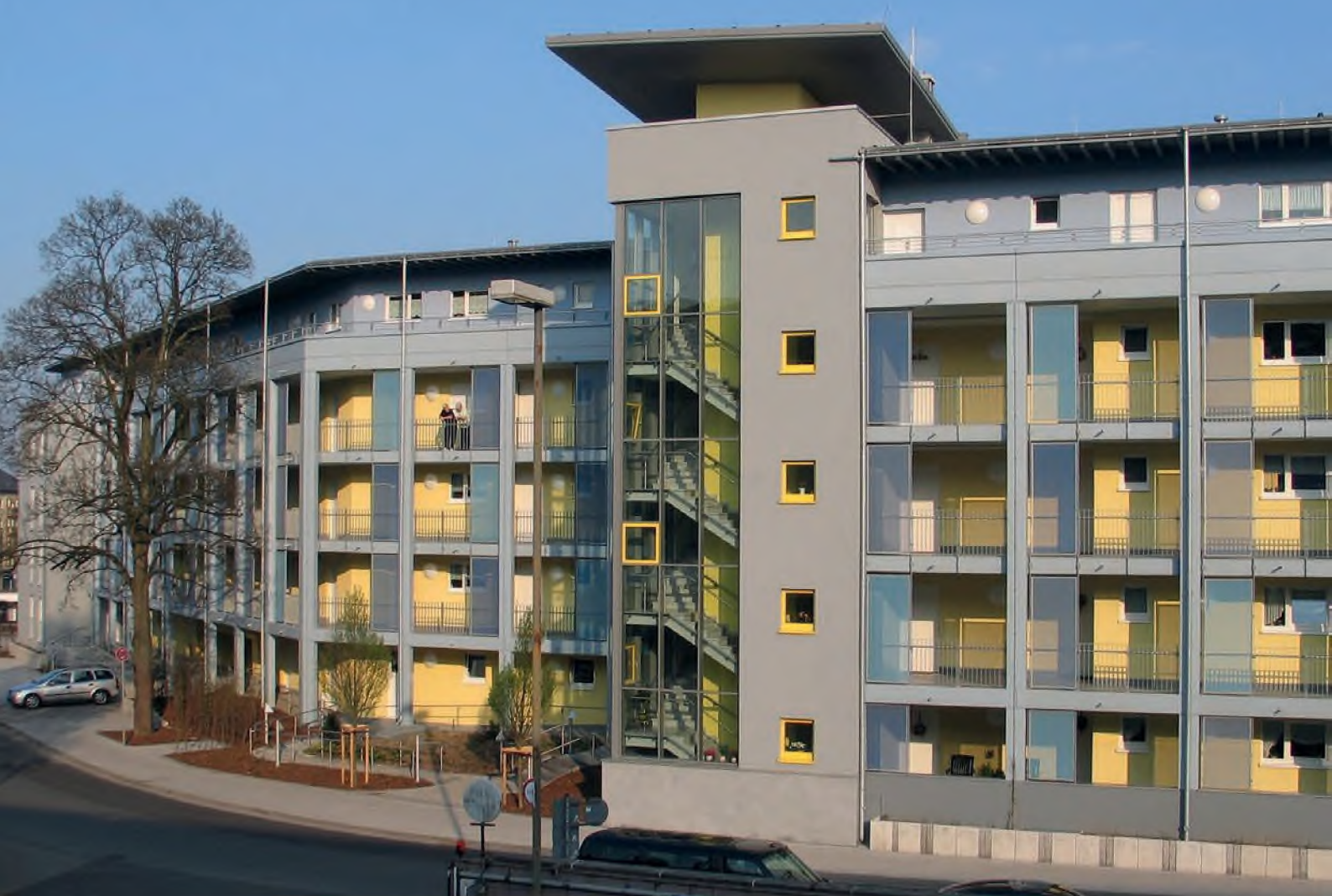
Solingen, Graf-Engelbert-Straße, 74 öffentlich geförderte Altenwohnungen mit ca. 100 PKW-Stellplätzen in einer zweigeschossigen Tiefgarage im innerstädtischen Bereich, 2004/2005, LPH. HOAI: 1 – 9
