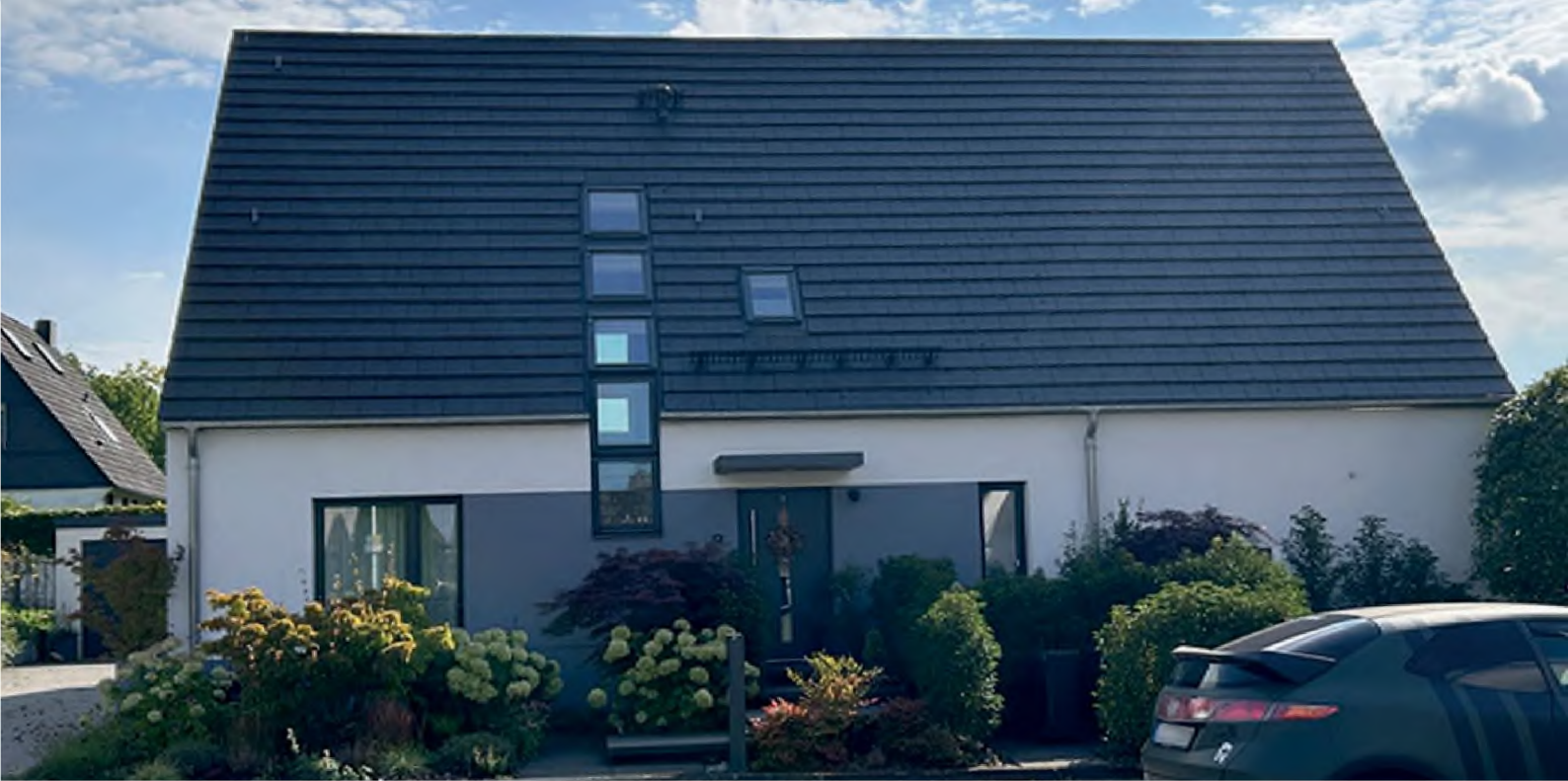
Solingen, Stettiner Straße, Umbau, Erweiterung und Instandsetzung eines freistehenden Einfamilienhauses, 2018/ 2019, LPH. HOAI: 1 – 8
