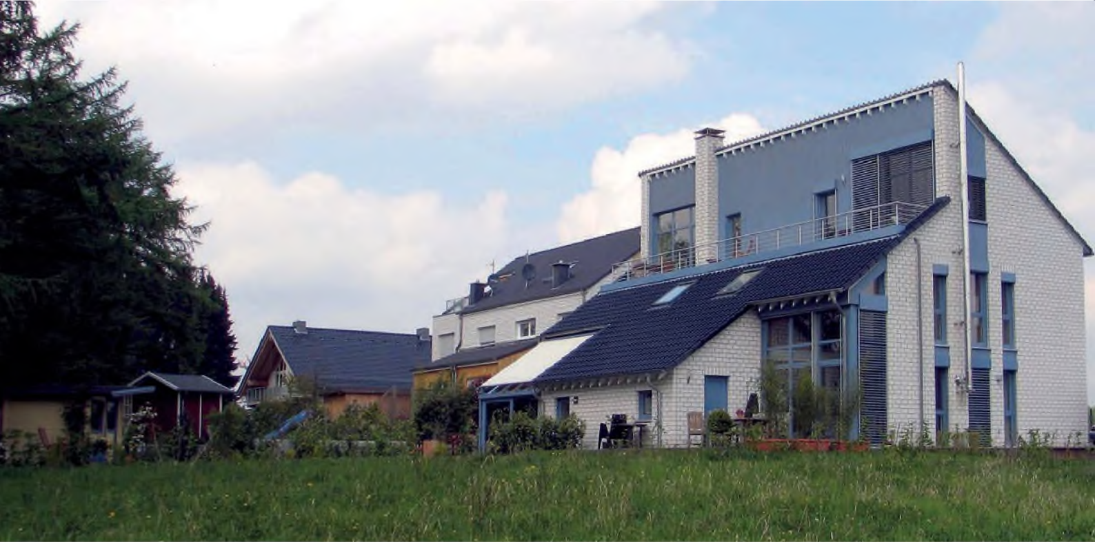
Solingen, Widdeter Straße, 4 Ein- bzw. Zweifamiliendoppelhaushälften, 2003, LPH. HOA: 1 – 5 und Projektentwicklungsleistungen für einen Bauträger nach vorausgegangener B-Planentwicklung
