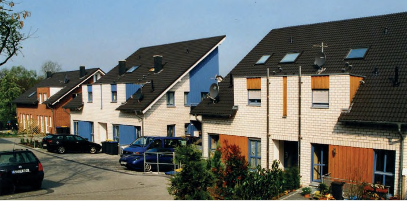
Solingen, Rolsberger Straße, 6 Doppelhaushälften mit 10 Wohneinheiten, 2000, LPH. HOAI 1 – 8
